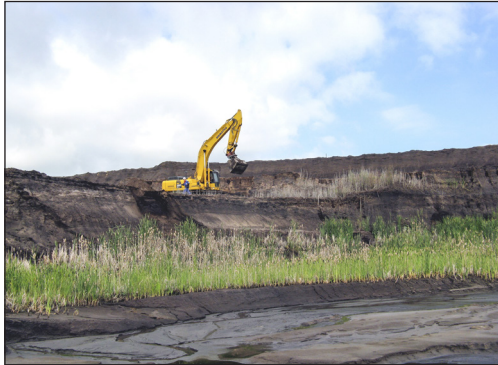
Abb. 11: Freilegung des Basisprofils an der nordwestlichen Tageauböschung.
